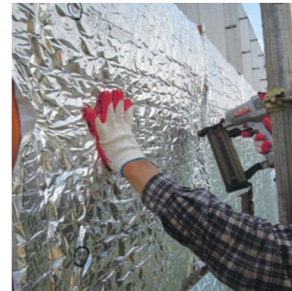
콘크리트 타카를 이용하여 벽면에 고정
