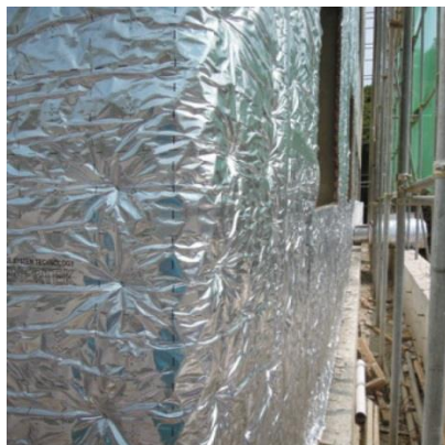
기둥, 보, 모서리 등 기밀 시공
